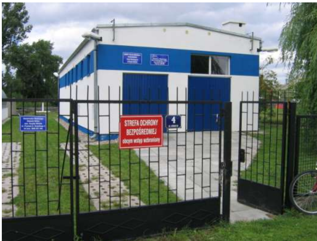
Fot. 5. Stacja uzdatniania wody w Krzycku Wielkim
