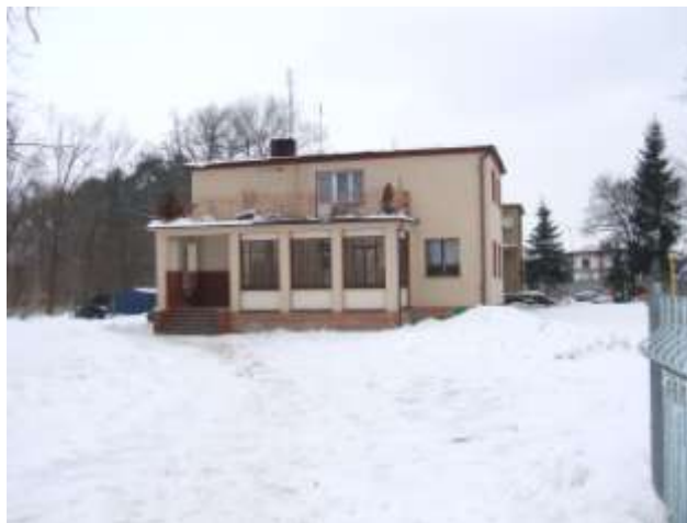
Fot. 8 Świetlica wiejska w Boguszynie
