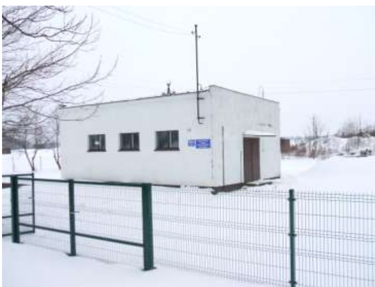
Fot. 5 Stacja uzdatniania wody w Boguszynie
