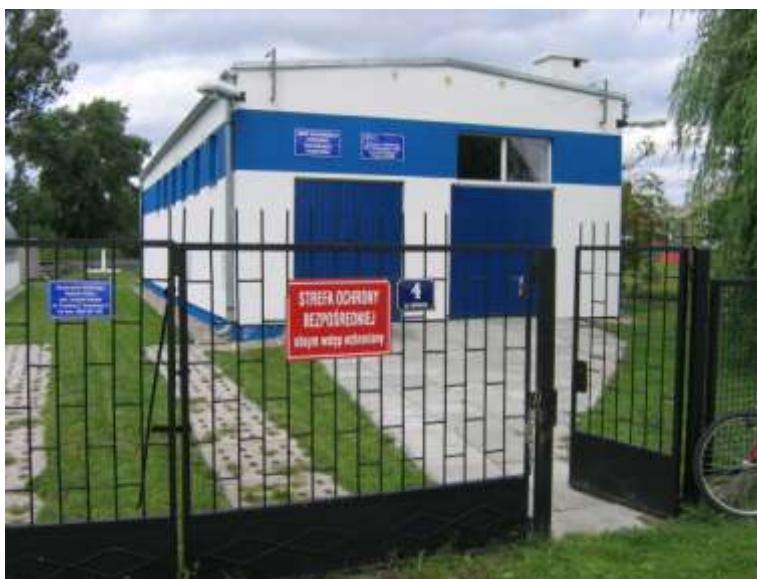
Fot. 6. Stacja uzdatniania wody w Krzycku Wielkim
