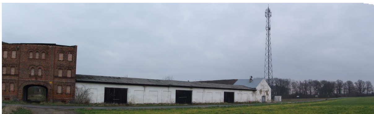
Ryc. 8. Stacja bazowa telefonii komórkowej w Zbarzewie.
