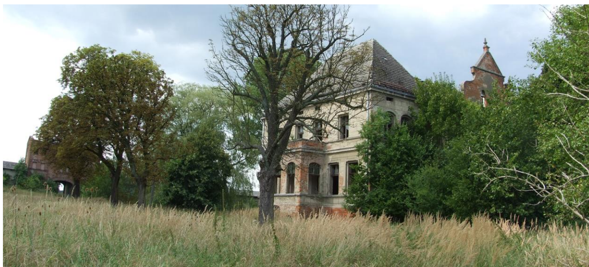
Ryc. 7. Samosiejne trawy na podwórku od strony obiektów folwarcznych.
